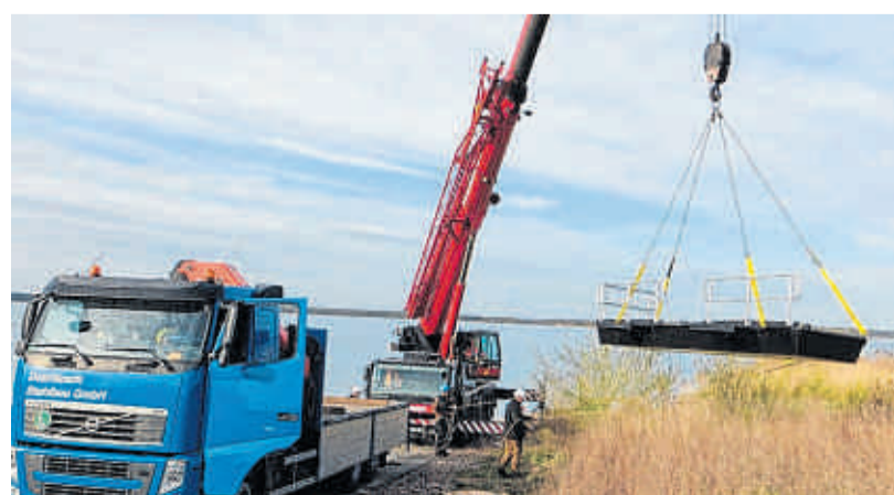
Der Steg wird ins Wasser gehoben.
